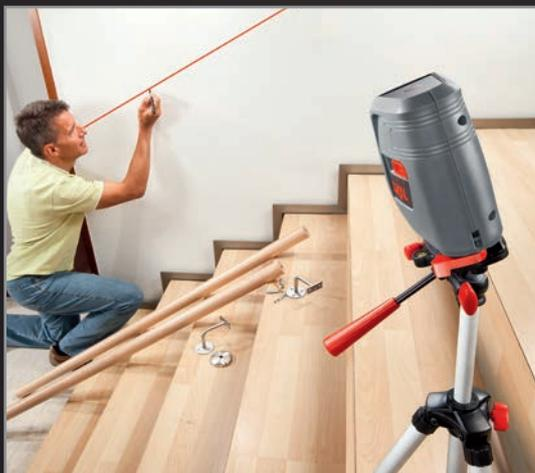
Función de inclinación para la instalación de barandas de escaleras y nivelación de rampas.
